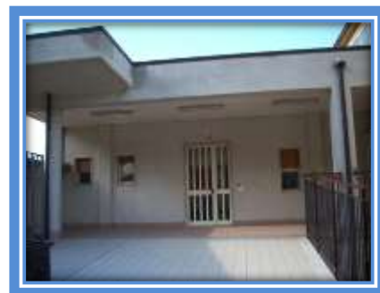
Plesso di Arpaia ingresso Scuola dell'Infanzia
